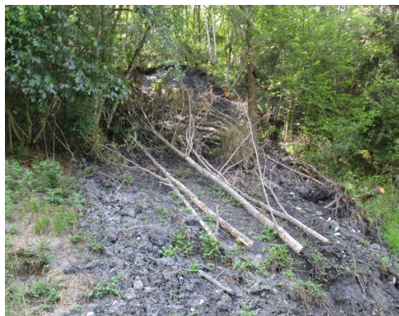
Figure 61: Glissement de talus récent sur la route de Plangerland (photo du 7 juillet 2018)
