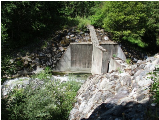
Figure 65: Plage de dépôt à l'amont du pont de la RD88
