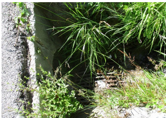
Figure 67: Entrée de la buse sous la route
