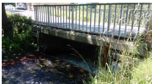
Figure 64: Pont de la route des Esserts
