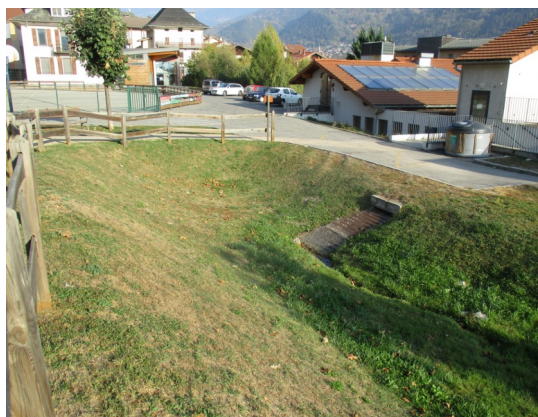
Figure 60: Bassin de décantation de la rue du Prince
