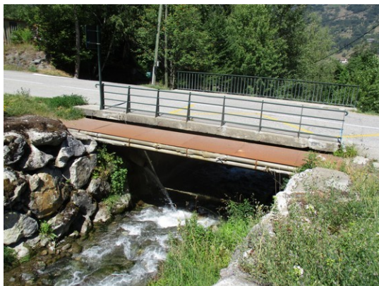
Figure 62: Pont de la RD 88
