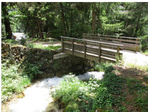
Figure 19: Passerelle sur la partie supérieure du cône de déjection
