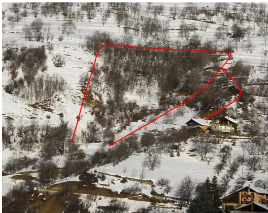
Figure 52: la combe gypseuse sujette à affaissement ou effondrement.
