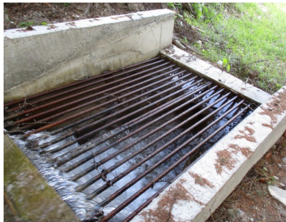
Figure 69: Grille à l'entrée de la section busée sous la piste de ski
