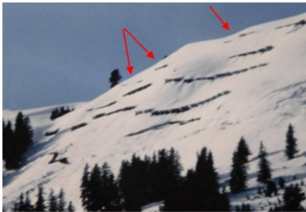
Figure 34: les écrans paravalanches du Mial à la fin des années 70 et en janvier 2012 (noter la surcharge des lignes amont).
