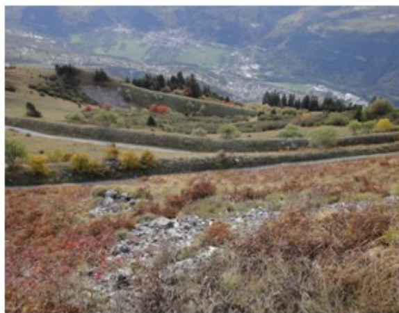
Figure 32: les banquettes larges en zone de départ
