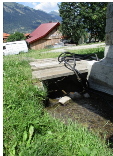
Figure 68: Entrée de la section couverte à côté du Moulin.
