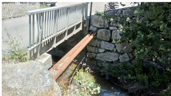
Figure 63: Pont au niveau de l'entreprise Loyet
