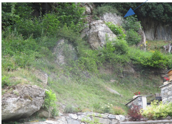
Figure 15: Bloc attaché par un câble
