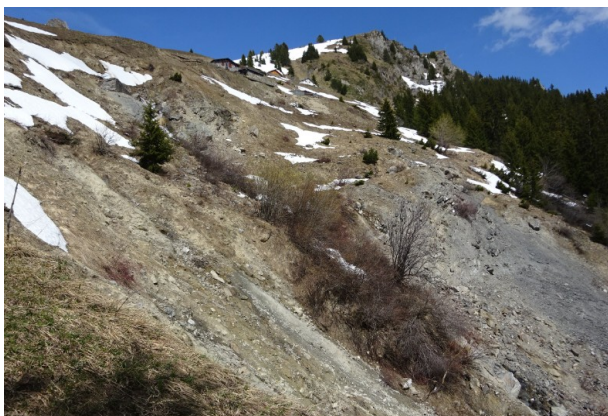
Figure 7: Vue d'ensemble du glissement du Chapelet
