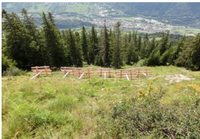
Figure 44: claies en bois installées en 2014.
