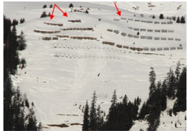
Figure 34: les écrans paravalanches du Mial à la fin des années 70 et en janvier 2012 (noter la surcharge des lignes amont).
