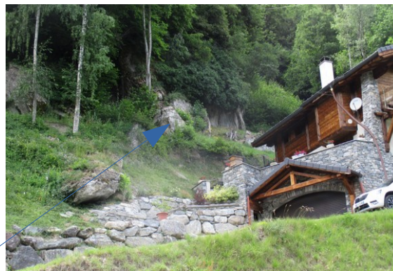
Figure 14: Affleurement rocheux à l'amont de deux maisons
