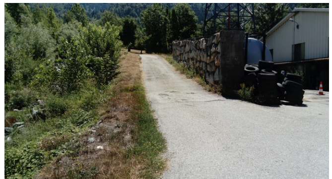
Figure 66: Digue de protection des hangars de l'entreprise Loyet
