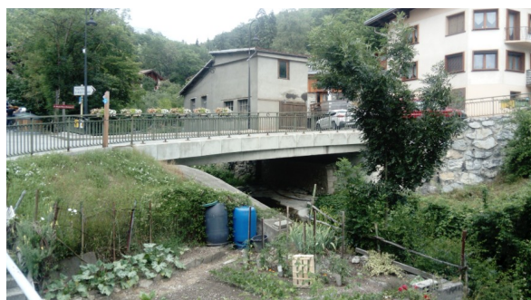
Figure 57: Pont de la RD 86
