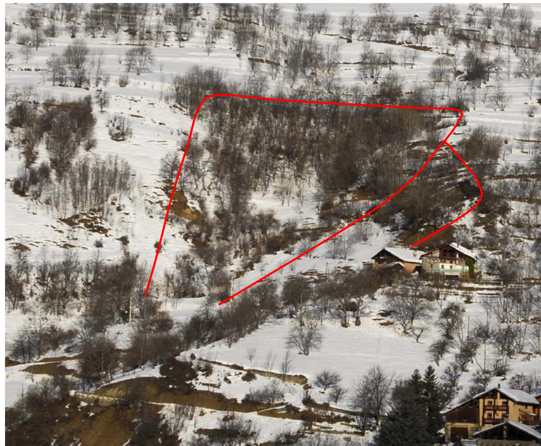
Fig. 32 : la pente morainique sujette à fluage, en amont des chalets des Chavonnes (à droite) et la combe gypseuse sujette à affaissement ou effondrement (à gauche).
