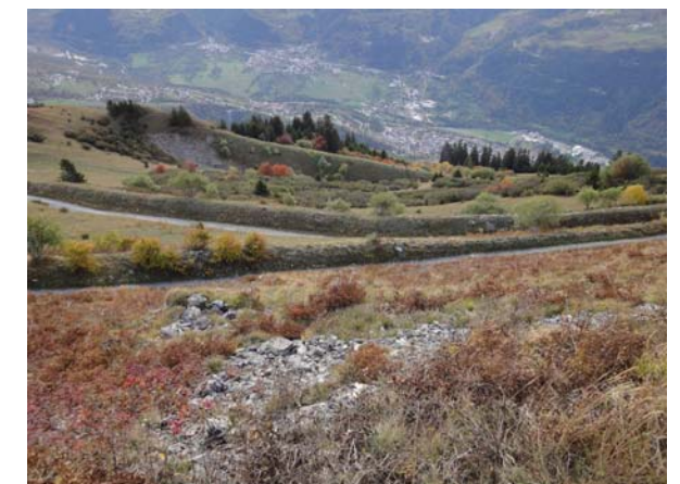
Fig.10 : les banquettes larges en zone de départ
