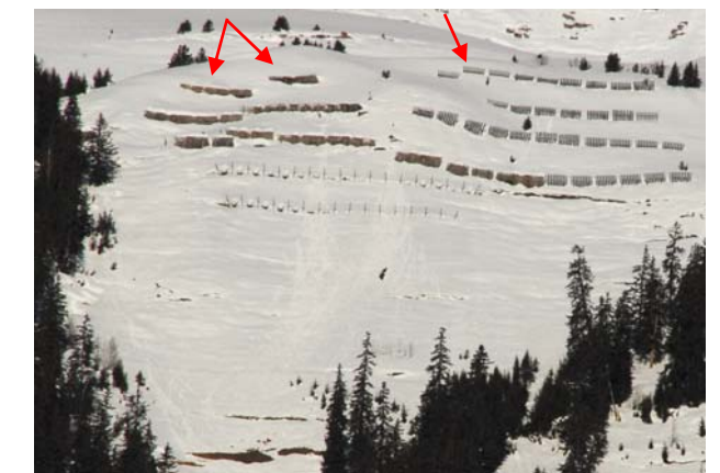
Fig.12 et 13 : les écrans paravalanches du Mial à la fin des années 70 et en janvier 2012 (noter la surcharge des lignes amont).
