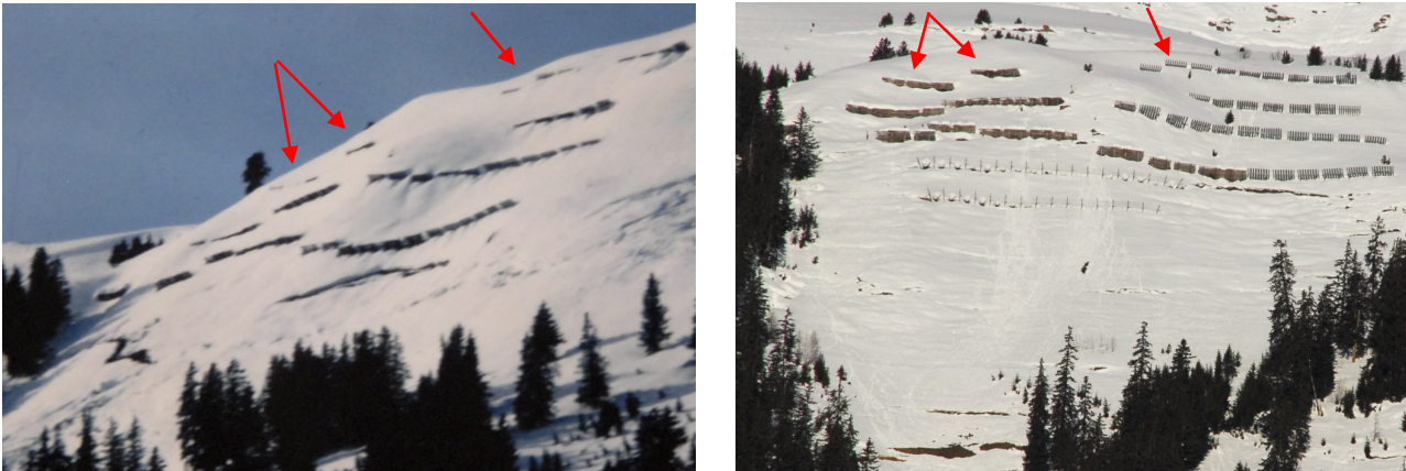
Fig.12 et 13 : les écrans paravalanches du Mial à la fin des années 70 et en janvier 2012 (noter la surcharge des lignes amont).
