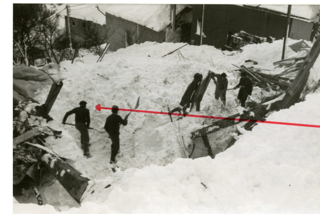
Fig.8 et 9 : emplacement du chalet Arnolet détruit (branche orientale) (photos Oggeri gendarmerie).
