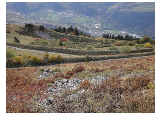
Fig.10 : les banquettes larges en zone de départ
