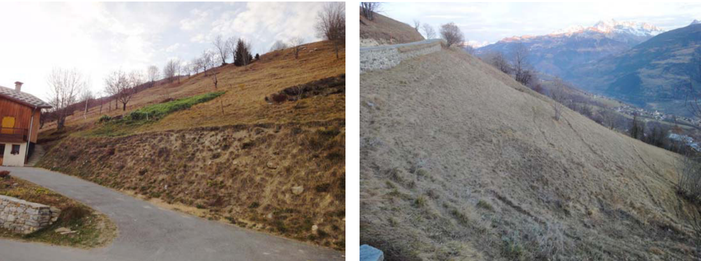
Fig. 30 et 31 : les talus sujets à fluage en amont du lotissement (à gauche) et du vieux village (à droite).
