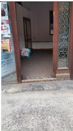
3 – Accès au hall principal
