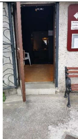
4 – Accès direct au hall d'entrée de la salle n°2
