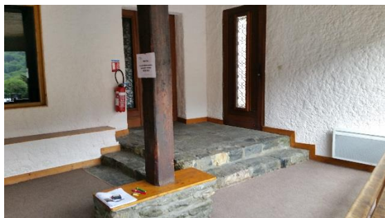
7 – Escalier hall d'entrée salle n°1
