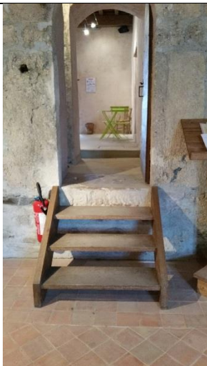
3 – Escalier entre l'accueil et la salle principale du RdC
