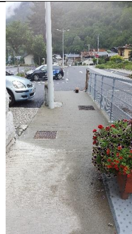
2 – Cheminement entre la place adaptée et l'entrée
