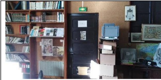
11 – Eclairage de sécurité
