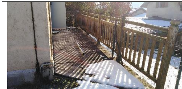
5 – Passerelle accès secondaire
