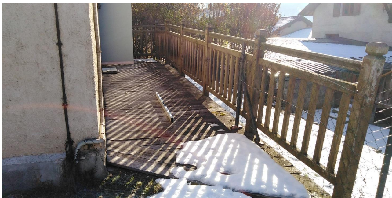
Passerelle en pente de 7% sur 6,40 m
