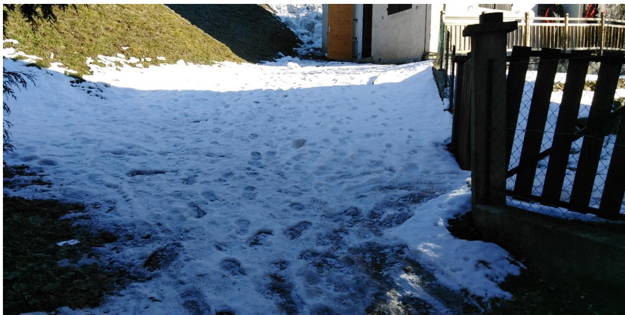
Pente importante dans le cheminement (jusqu'à 22% sur 25 ml)
