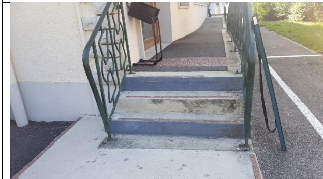
3 – Escalier extérieur et rampes d'accès
