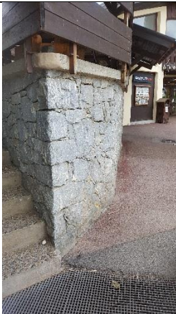
5 – Emplacement pour futur élévateur
