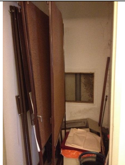
8 – Local de rangement dans bloc sanitaire avec trappe
