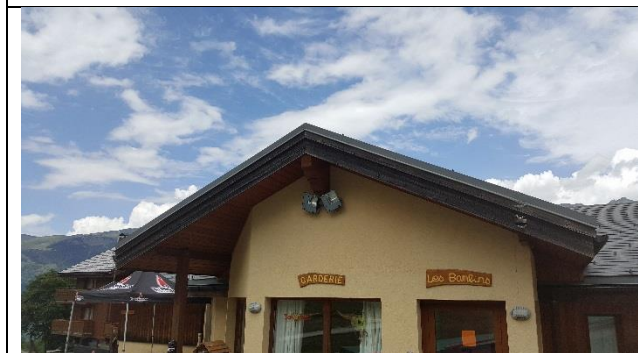
3 – Vue d'ensemble de l'établissement
