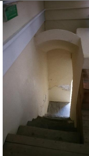
6 – Escalier desservant la mezzanine
