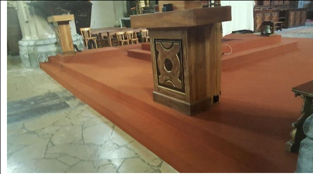
7 – Marches isolées pour accéder au transept
