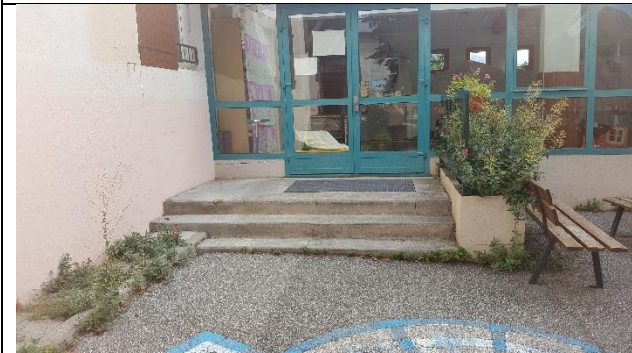
3 – Entrée salle de motricité (RdC inf)
