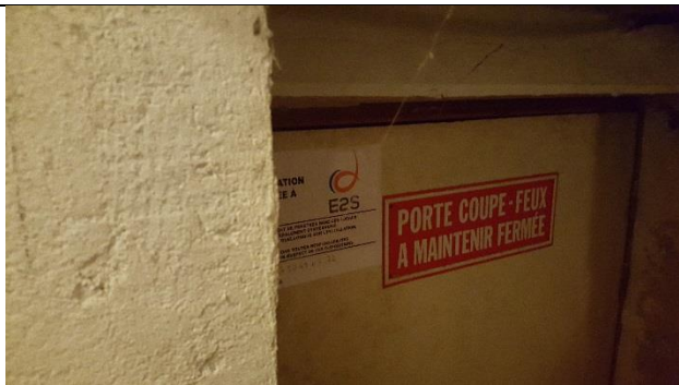
11 – Porte chaufferie au sous-sol
