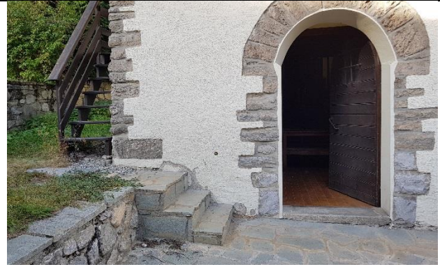
4 – Escaliers extérieurs menant à la mezzanine
