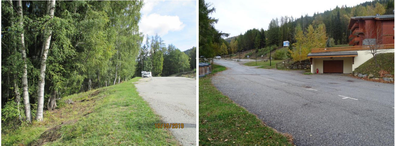
Vue sur le parking existant depuis l'Ouest et les résidences à l'aval-2019
