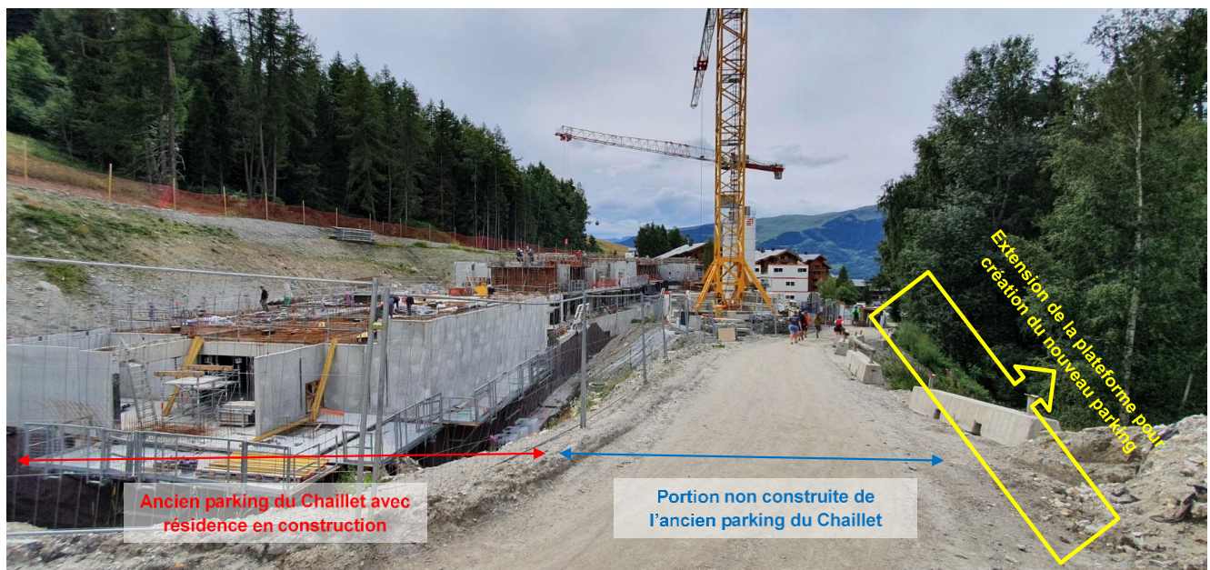
Vue depuis l'est avec résidence en construction
