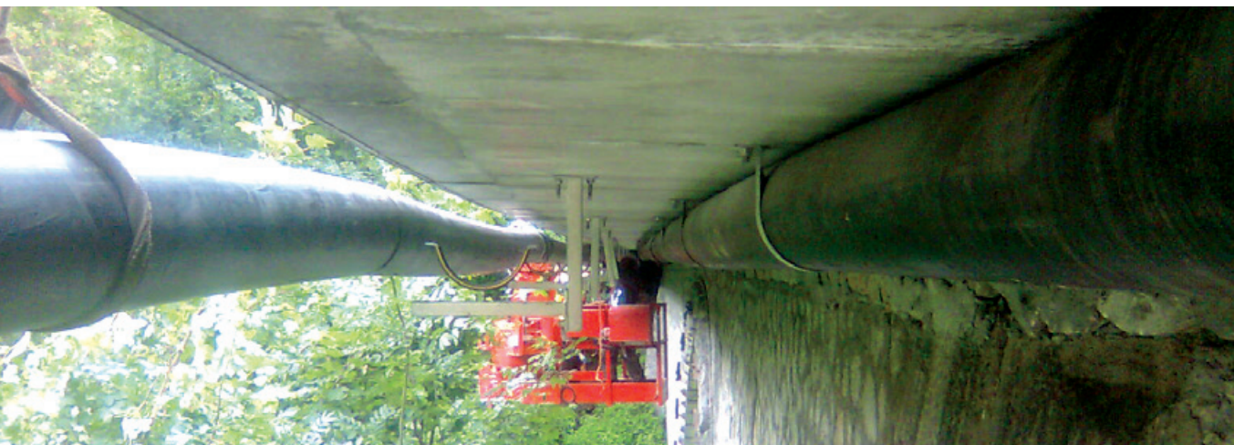
➤ Fixation de la conduite d'eau en encorbellement sous le pont de la Tour à Villette
