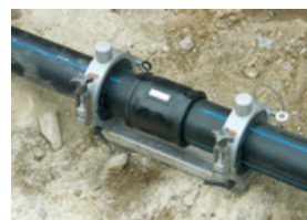
➤ Soudage d'un manchon en phase chantier
