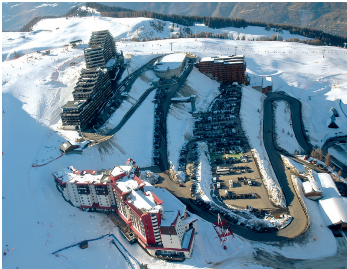
Vue d'ensemble de la station de Plagne Aime 2000.
